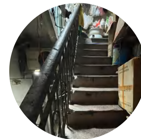
④ 193号室内楼梯
