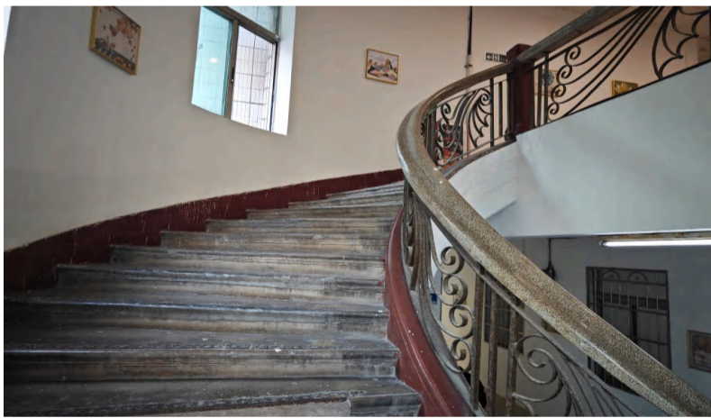
材料：砂浆、铸铁
