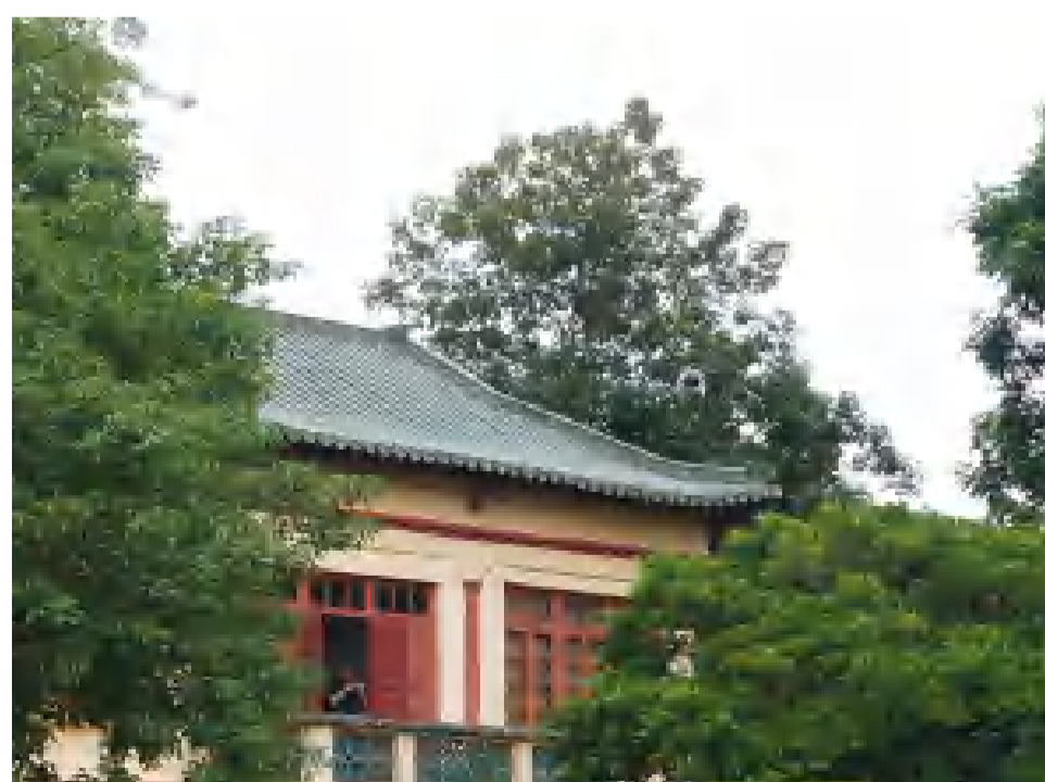
琉璃瓦歇山顶屋面
