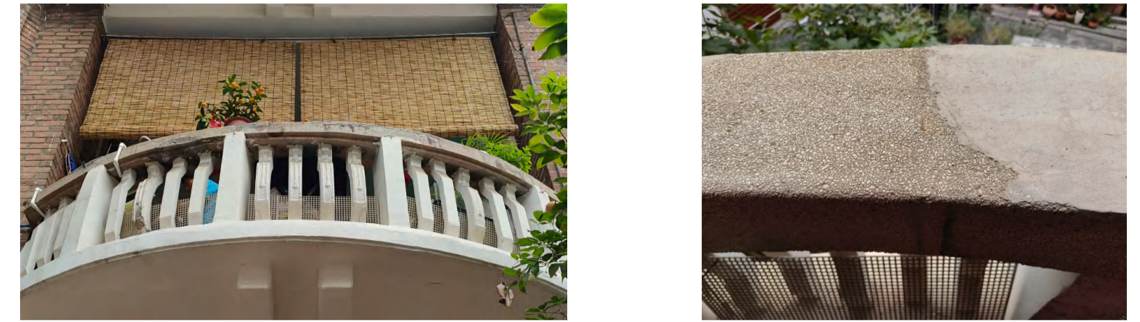
材料：预制混凝土、水刷石
