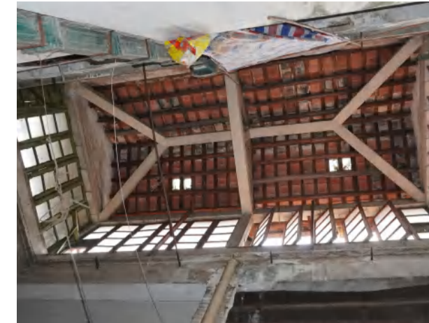
材料：木、陶瓦、混凝土
