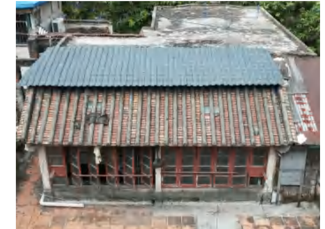
材料：木、陶瓦、混凝土
