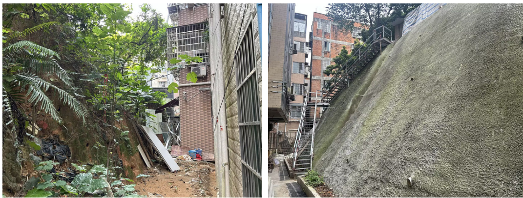
图 2.23 锚杆喷射混凝土治理前后照片
