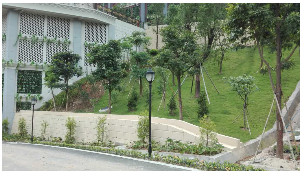
图 2.7 重力式（直立式）挡墙+放坡支护治理后现场照片
