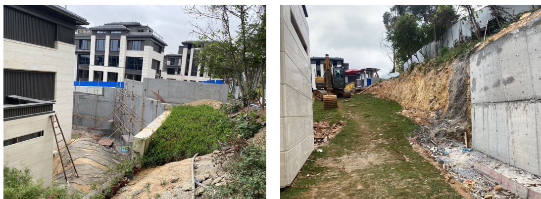
图 2.13 悬臂式钢筋混凝土挡土墙治理过程现场照片
