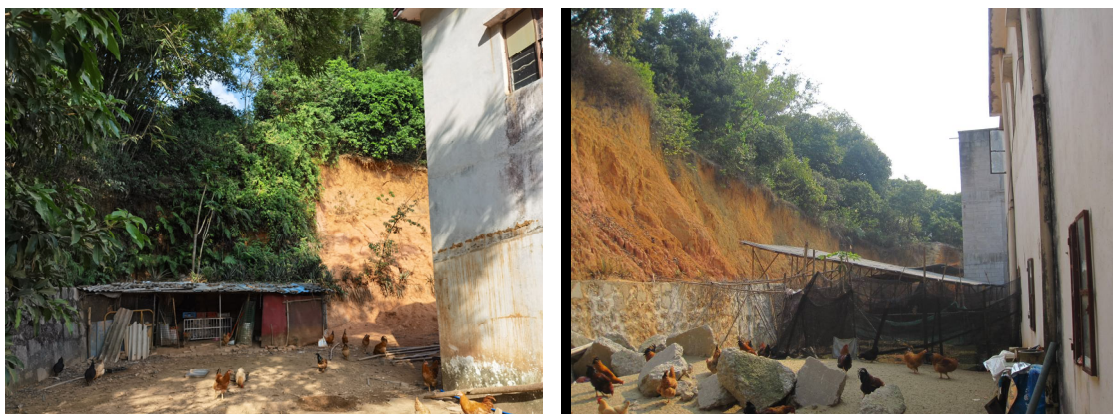
图 2.10 重力式（直立式）挡土墙+放坡支护治理前现场照片（靠近民房，局部崩塌）
