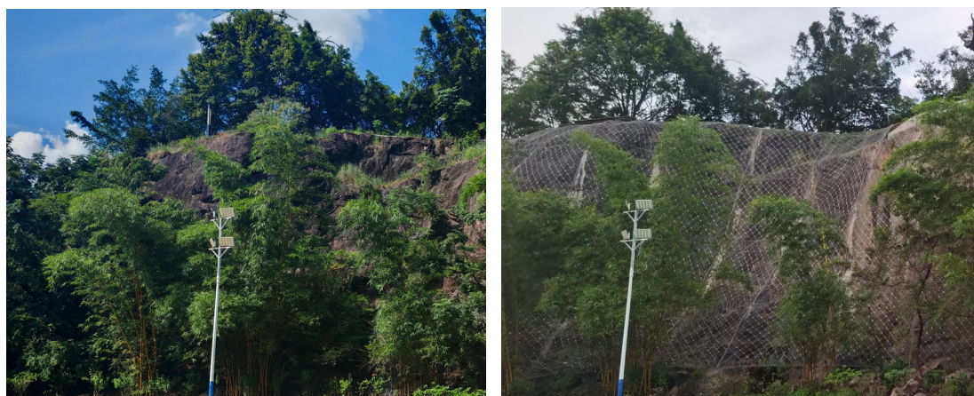
图 2.15 岩质边坡主动防护网治理前后照片
