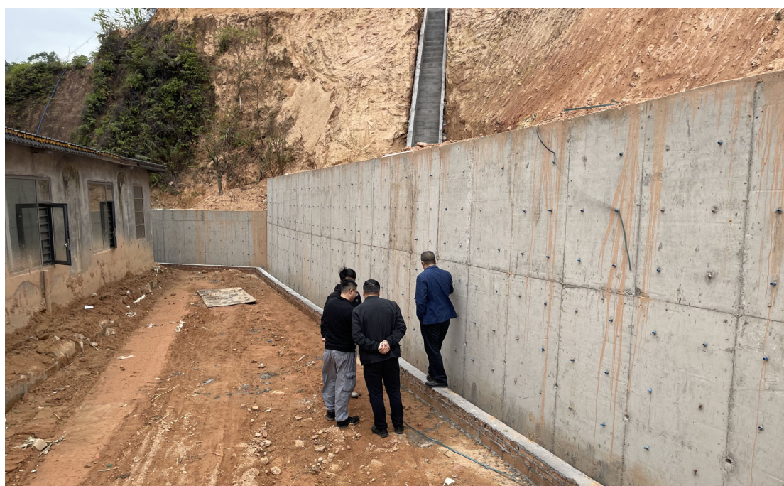
图 2.26 挡土墙厚度设置不足、墙顶放坡偏陡
