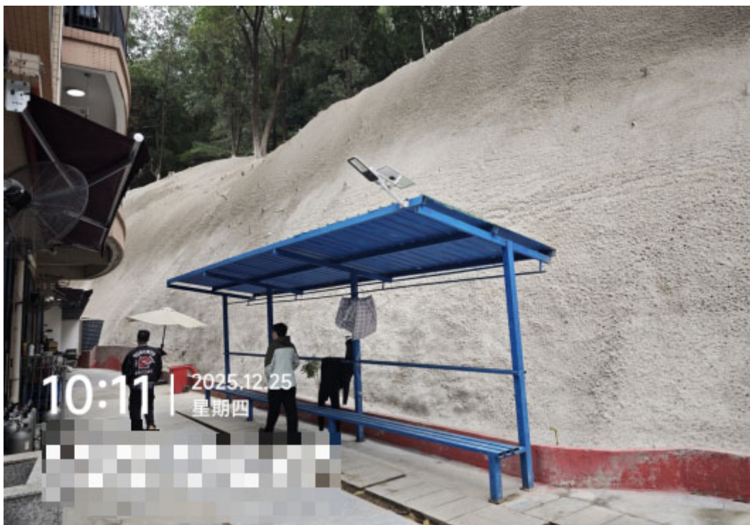
图 2.27 喷砼面未设泄水管
