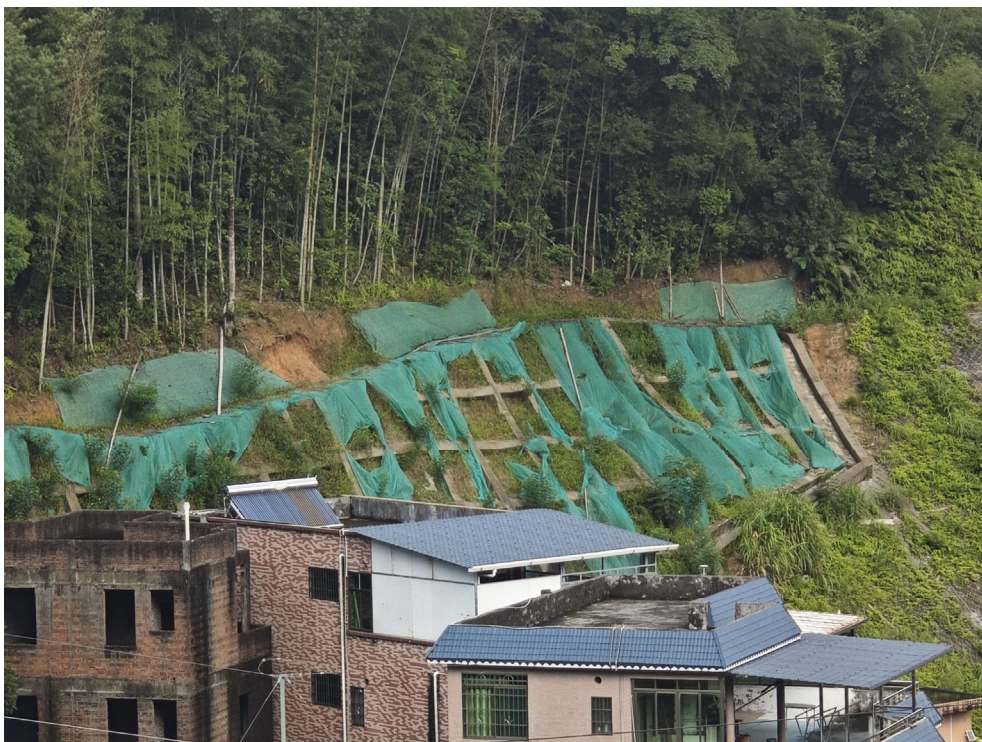
图 2.29 坡顶截水沟上部坡面偏陡、未防护
