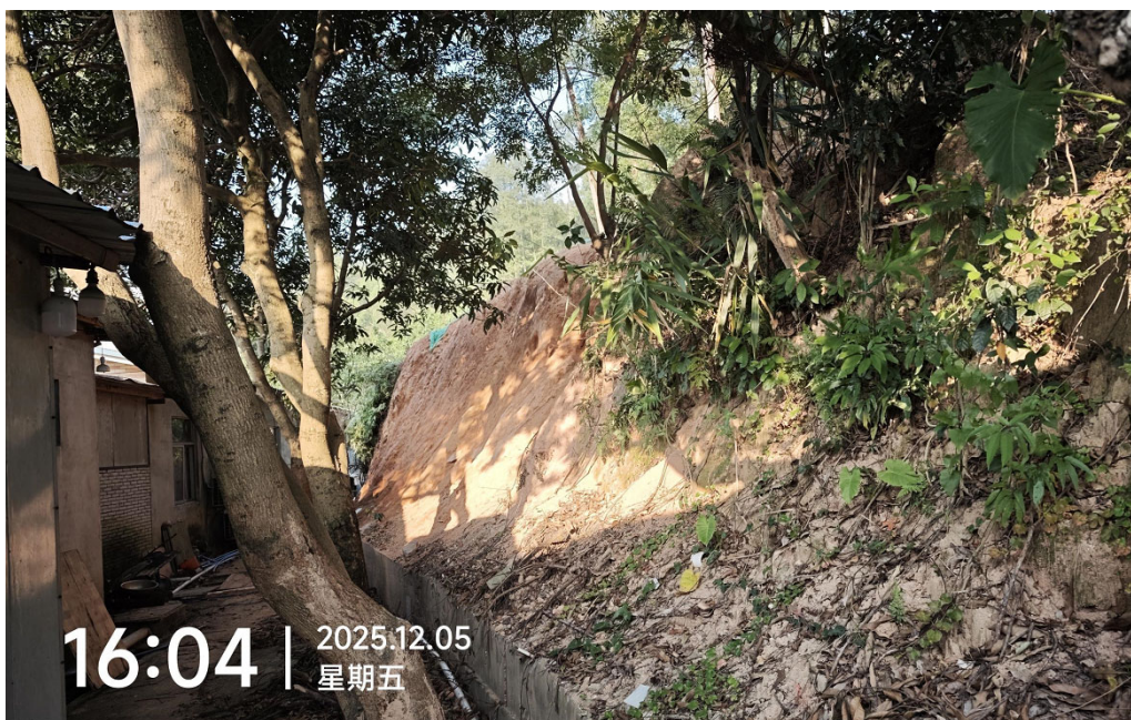
图 2.24 坡率偏陡、坡面裸露
