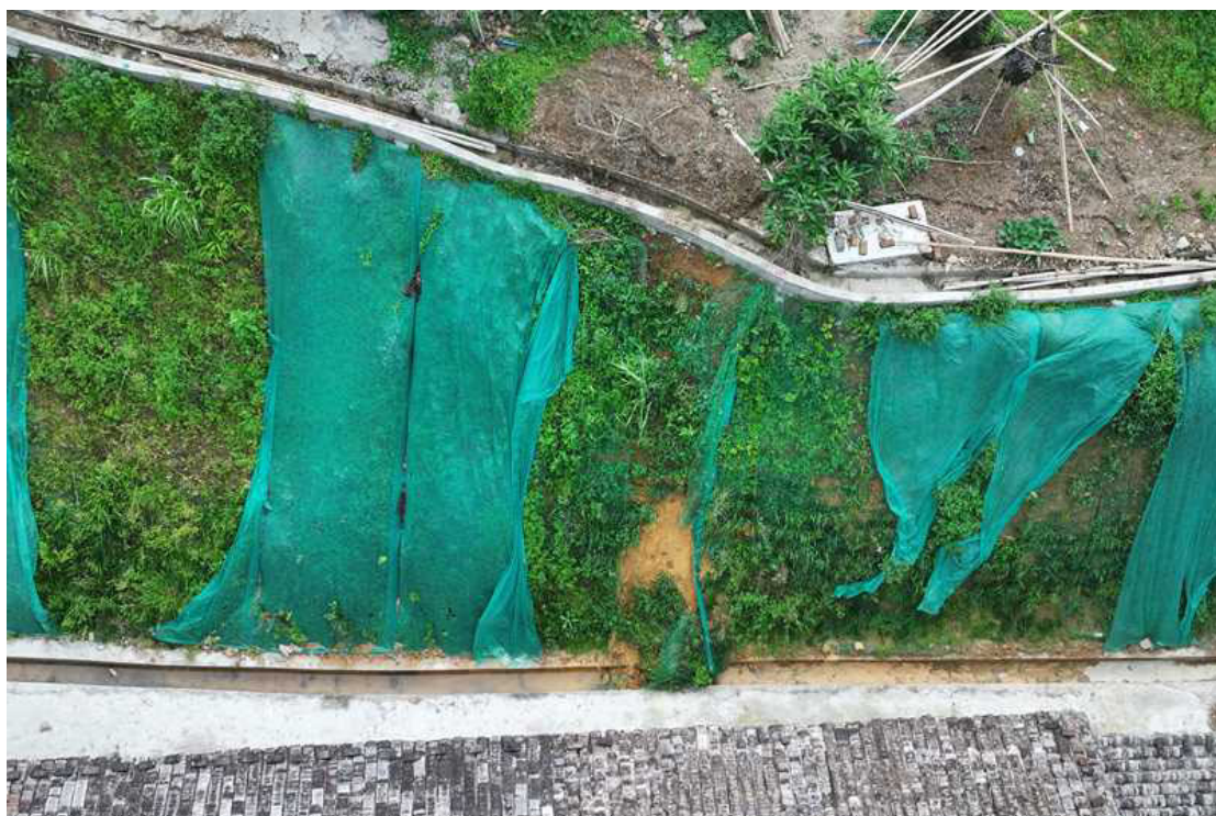
图 2.30 放坡坡度过陡、坡顶截水沟排水不畅
