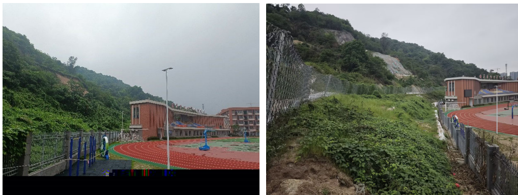
图 2.17 岩质边坡被动防护网治理前后照片
