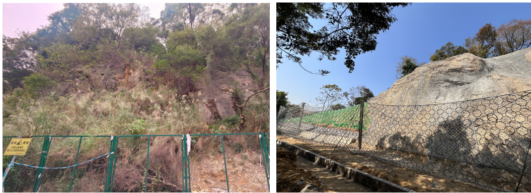
图 2.19 岩质边坡主动防护网+被动防护网治理前后现场照片
